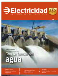
Apertura de compuertas hacia el vertedero de la obra de toma de una central hidroeléctrica. Foto: Gentileza Andritz
