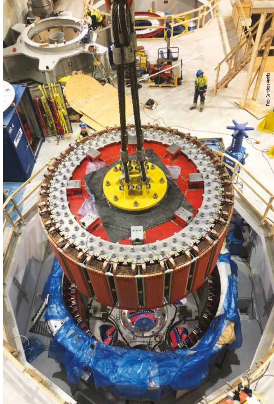
» Instalación de un generador en una central hidroeléctrica.
